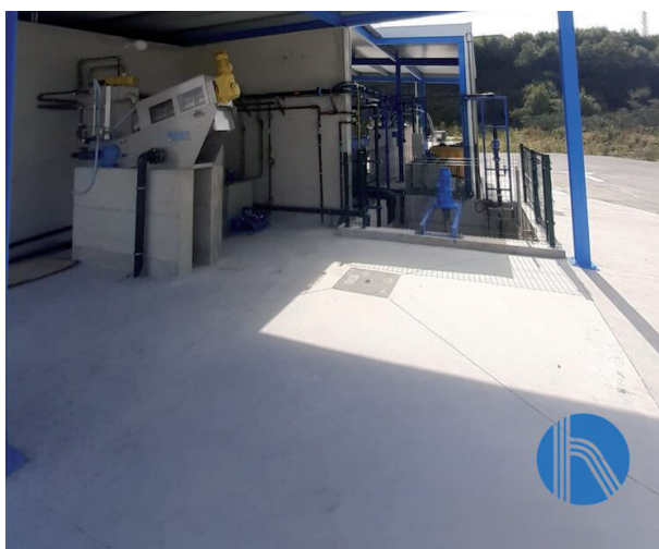
FIGURA 7. Vista tornillo del deshidratador de fangos
