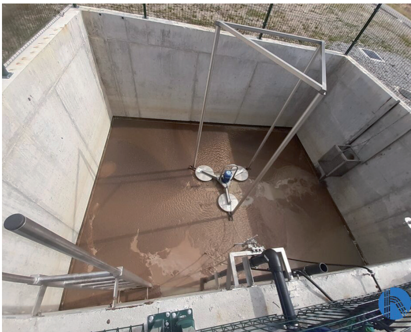
FIGURA 2. Vista de la arqueta de homogenización
