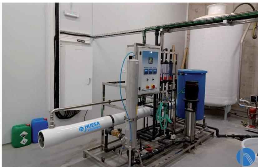
FIGURA 3. Vista del remineralizador y del sistema de cloración en continuo
