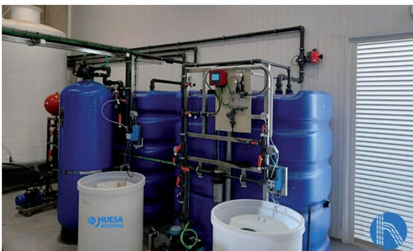
El permeado de la planta de ósmosis inversa se acumula en un tanque de acumulación de PRFV de 10 m<sup>3</sup> de capacidad. Este depósito será el punto de consumo de agua para la caldera y, a su vez, alimentará a un equipo remineralizador (ver Figura 2).
