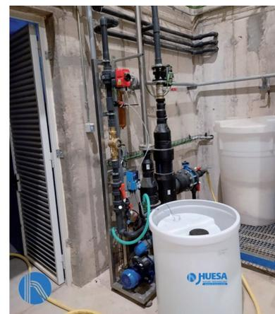
menos del pretratamiento instalado. La planta de ósmosis inversa incluye un sistema de lavado de membranas constituido por un depósito de 300 litros de preparación de reactivos, bomba de recirculación en inoxidable
